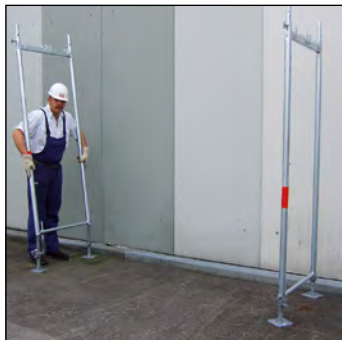
Vertikalrahmen aufstecken
