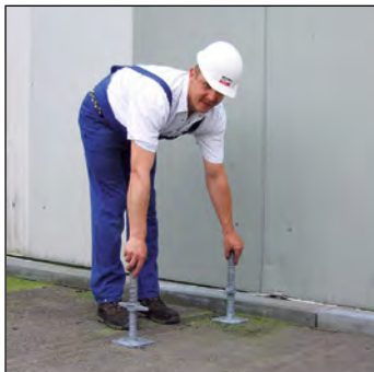
Gewindefußplatten aufstellen
